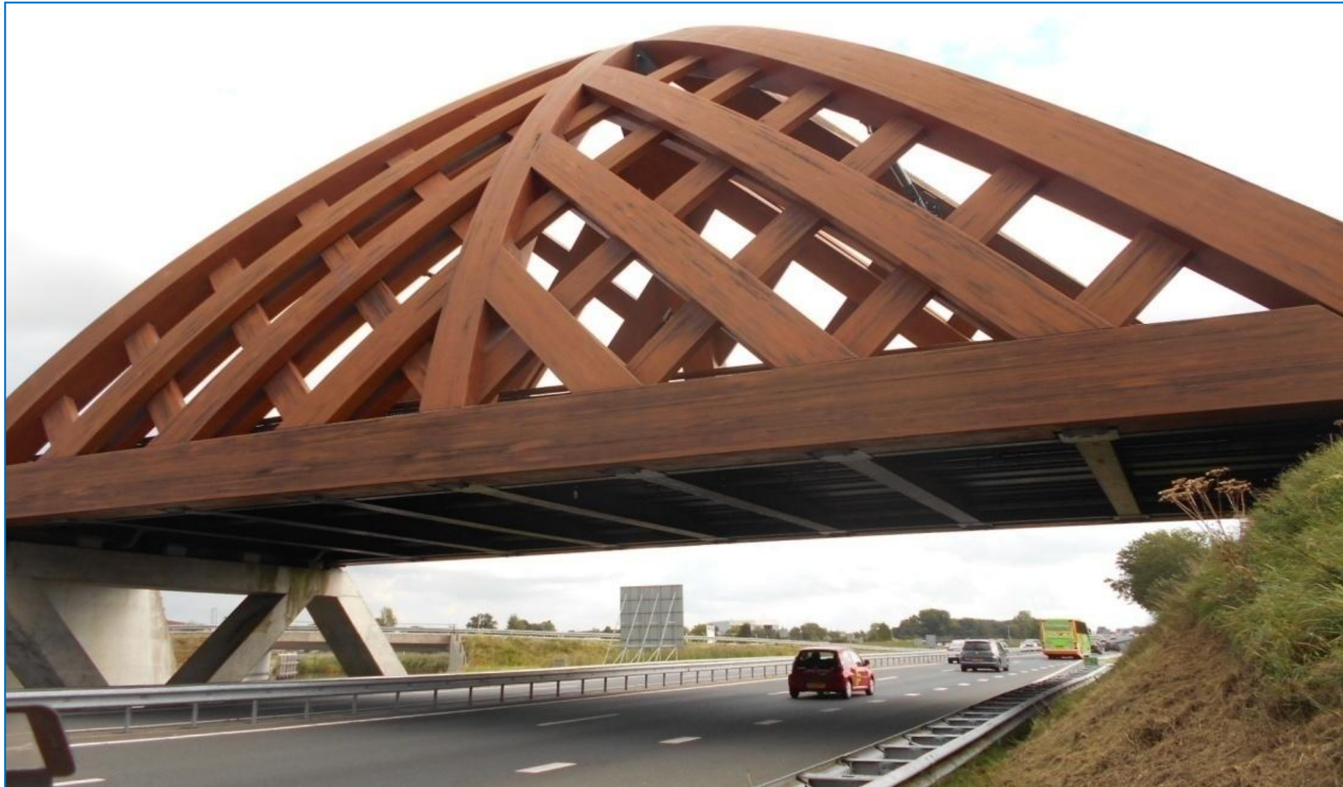
Puentes de madera laminada acetilada, autopista A-7 Sneek, Holanda (2010).
